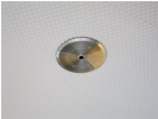
Einbauübersicht des Duftauslasses
