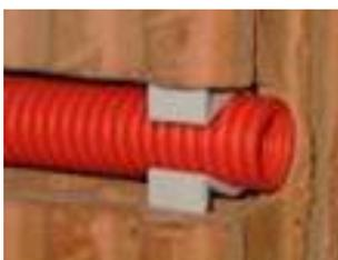
Bei unzugänglichen Abschnitten sollte ein Elektroleerrohr verlegt werden, um einen eventuellen Austausch zu gewährleisten.
